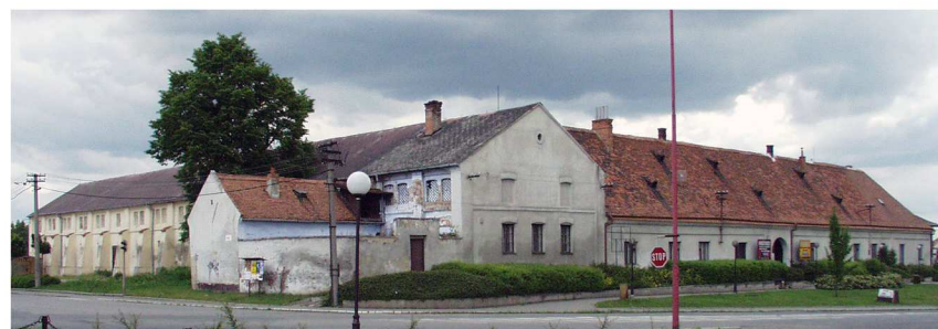
stav před rekonstrukcí
