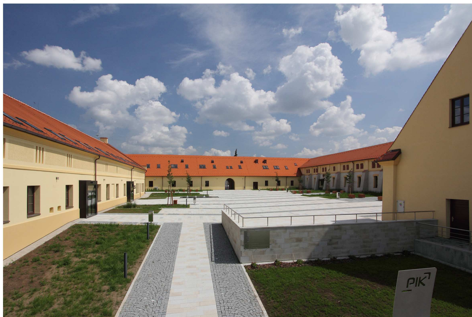
pohled na nádvoří
